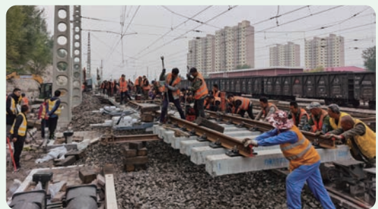
专用线铺轨作业现场
