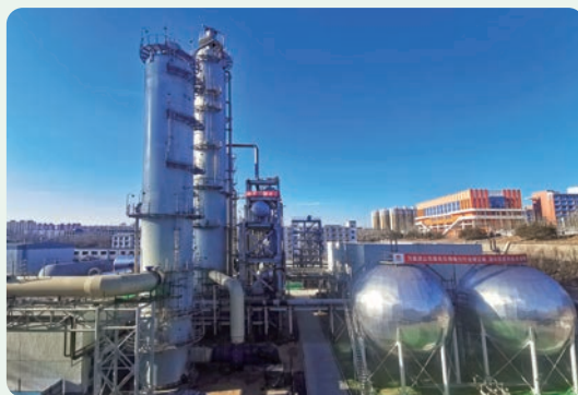
锦界能源CCS示范工程项目现场
